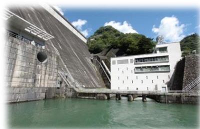
多摩川第一発電所
