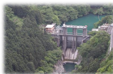
白丸調整池ダム
